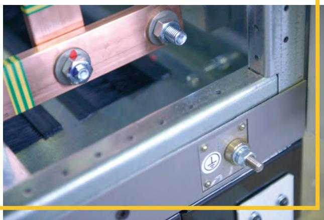
Узел, позволяющий выполнять видимое заземление
